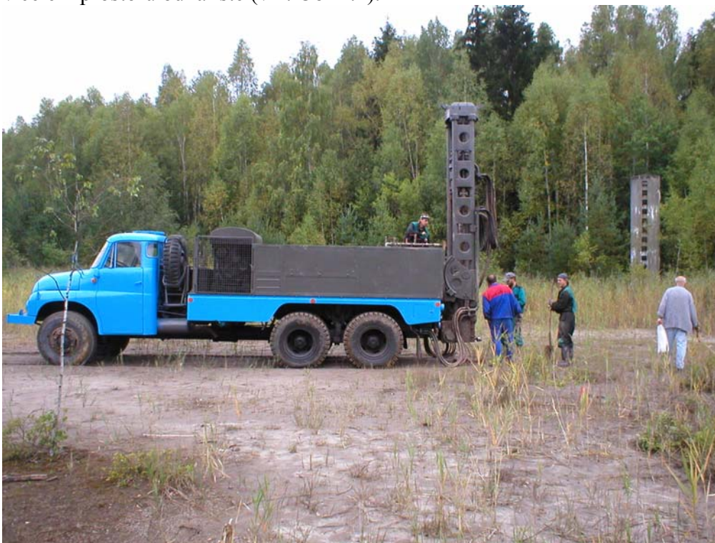
Obr.2.2: Vrtné práce v tělese odkaliště na lokalitě Jívka
