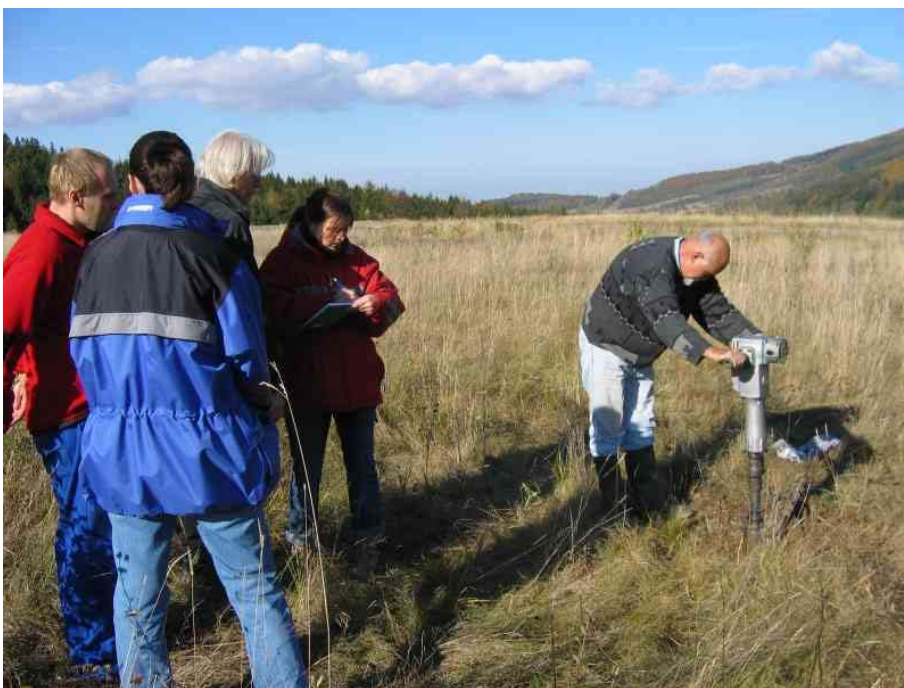
Obr. 2.3.: Vrtné práce v tělese odkaliště na lokalitě Zlaté Hory
