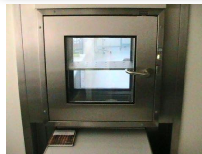
Uzavřená a otevřená materiálová propust'
