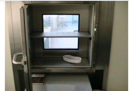
Uzavřená a otevřená materiálová propust'
