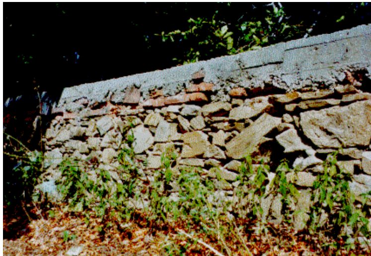
Obr. 4: Renovovaná koruna zdi.
