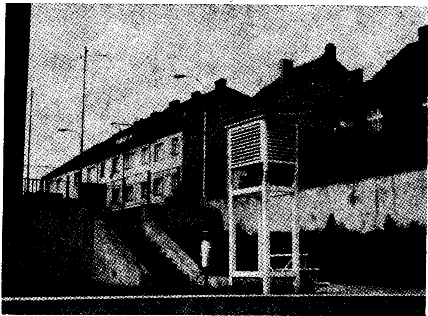
Obr. 2. Účelová stanice HMÚ v Brně-Žabovřeskách. Pohled od jihovýchodu. Foto autor
