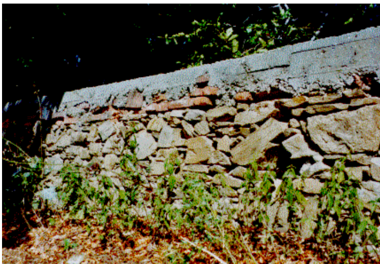
Obr. 4: Renovovaná koruna zdi.
